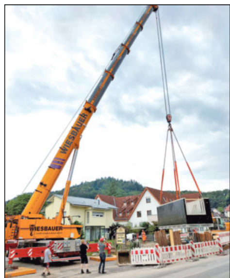
Die Einzelteile des Beckens wurden vor Ort zusammengesetzt. Foto: K
