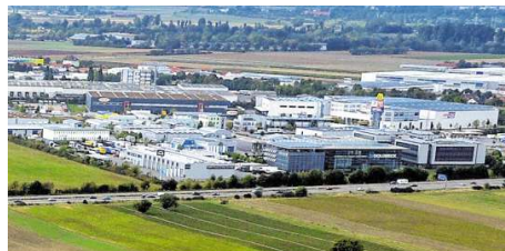
Der Gewerbepark in Hirschberg an der Autobahn 5. BILD: WOLFRÜDGER PFRANG
